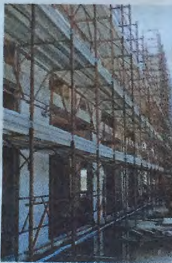
Un cantiere edile
