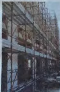
Un cantiere edile
