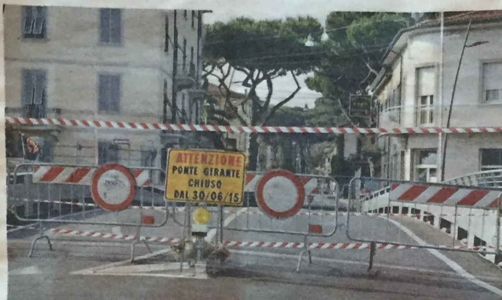
Il ponte girante chiuso
